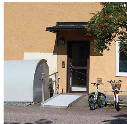
Exempel på bostadsanpassning: ramp till porten samt permobilgarage.
