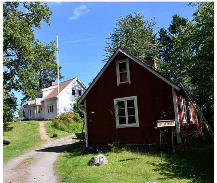
Mossberga 6, "Hemtorp" med byggnad 2 i förgrunden och byggnad 3 i bakgrunden , foto WSP, gul klassning
