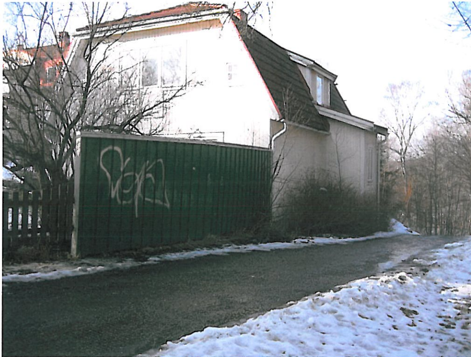
Befintlig östra flygel som avses rivas efter utförd kulturmiljödokumentation.
