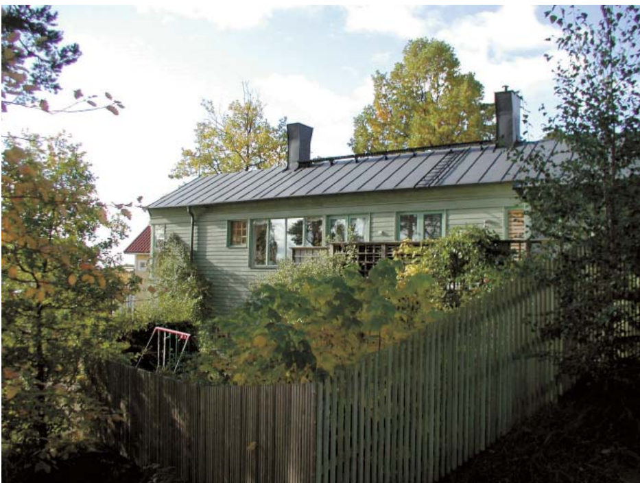
bandtäckt plåttak i svart kulör
