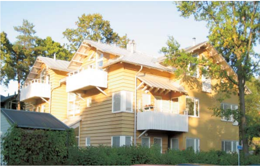
bandtäckt plåttak och synliga taktassar
