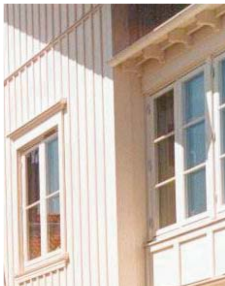
midjeplåt och knutar i samma kulör som fasaden
