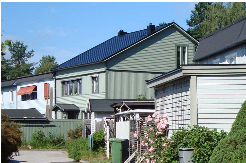
Bra exempel på vindspåbyggnad med sadeltak i kvarteret Orrtuppen.
