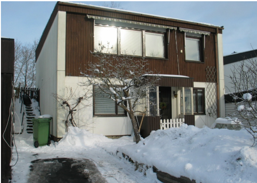
Kedjehus med färgsättning i originalutförande.
