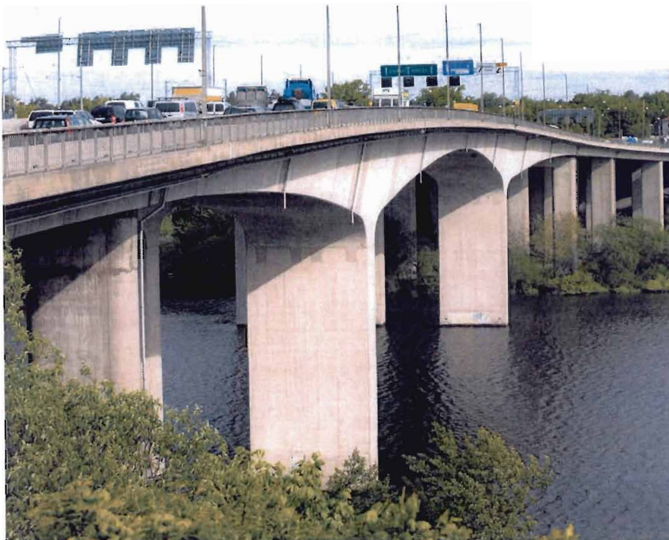
Essingeleden är den hårdast utnyttjade trafikleden i regionen och samtidigt mycket känslig för störningar.
